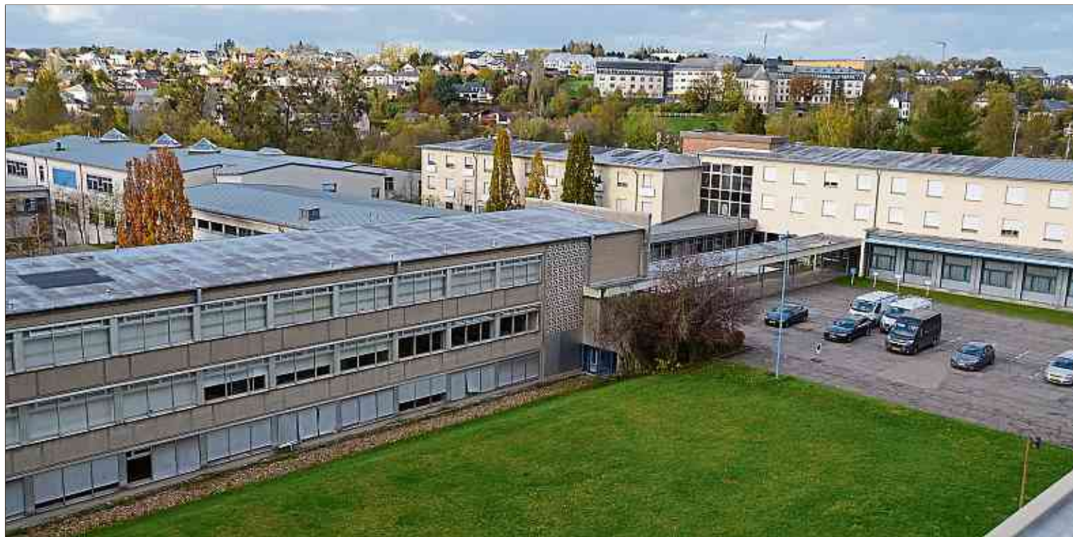
Der Schulflügel vorne links wird abgerissen und durch einen neuen, größeren Bau ersetzt. Das Internatsgebäude im Hintergrund wird entkernt und komplett saniert. (FOTOS: FRANK WEYRICH)
