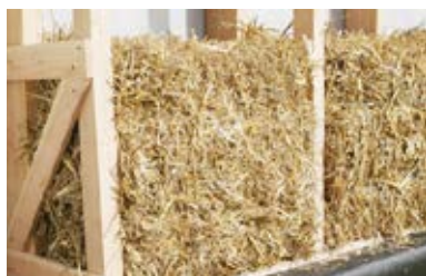
Système d'isolation en bottes de paille
